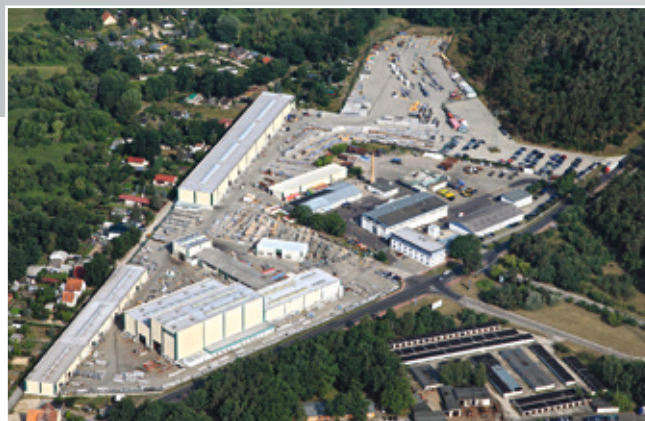
BUTTING Anlagenbau in Schwedt
